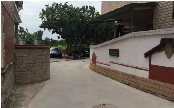
改造后：拓宽道路打通了微循环
